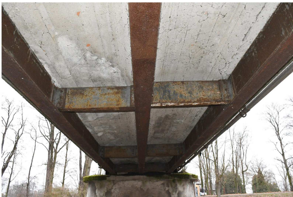
Fot. 13 Dźwigary główne, płyta pomostowa - przęsło skrajne
