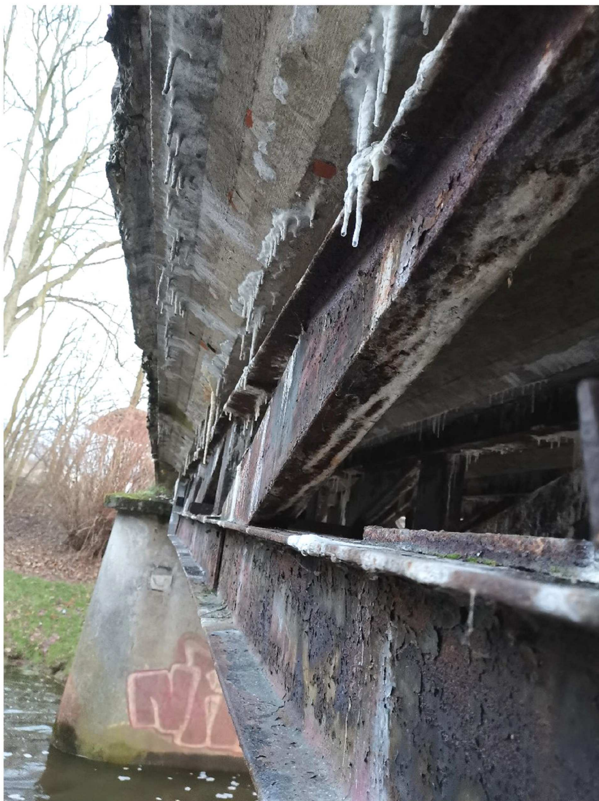
Pas dolny kratownicy w miejscach silniejszej korozji - przed oczyszczeniem z produktów korozji
