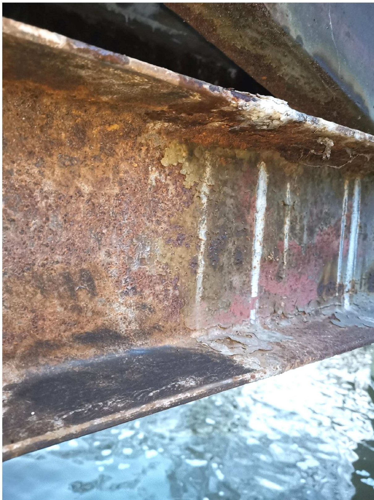
Pas dolny kratownicy po oczyszczeniu z produktów korozji
