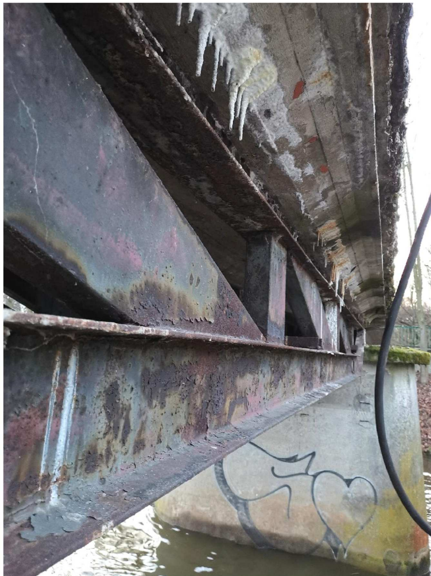
Stan dźwigara w miejscach o nieznacznej korozji powierzchniowej, widoczne resztki powłok malarskich.
