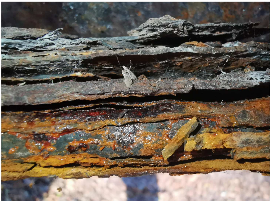
Fot. 23 Konstrukcja stalowa - zbliżenie uszkodzeń Rozległe uszkodzenia korozyjne pasa dolnego dźwigara kratownicowego.
