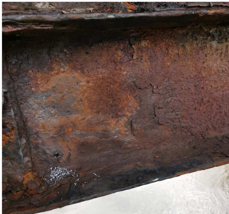
Fot. 25 Konstrukcja stalowa - uszkodzenia po oczyszczeniu Dokonano oczyszczenia skorodowanego pasa dolnego kratownicy. Bardzo duża ilość materiału uległa całkowitemu przekorodowaniu. Wyniki pomiarów opisane zostaną w dalszej części opracowania - punkt 9. Dokumentacja przeprowadzonych badań i pomiarów.
