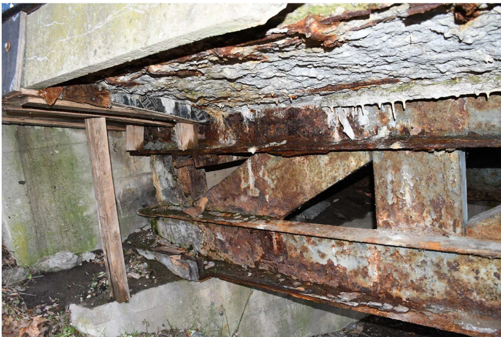
Fot. 14 Wspornik podchodnikowy, konstrukcja stalowa
