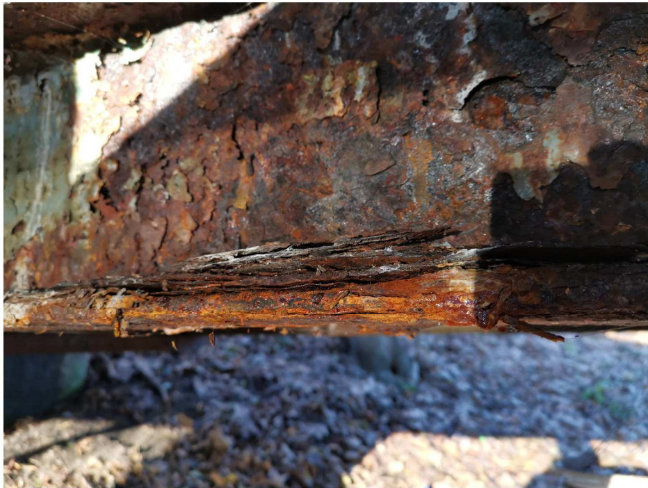
Fot. 22 Konstrukcja stalowa - zbliżenie uszkodzeń Rozległe uszkodzenia korozyjne pasa dolnego dźwigara kratownicowego.
