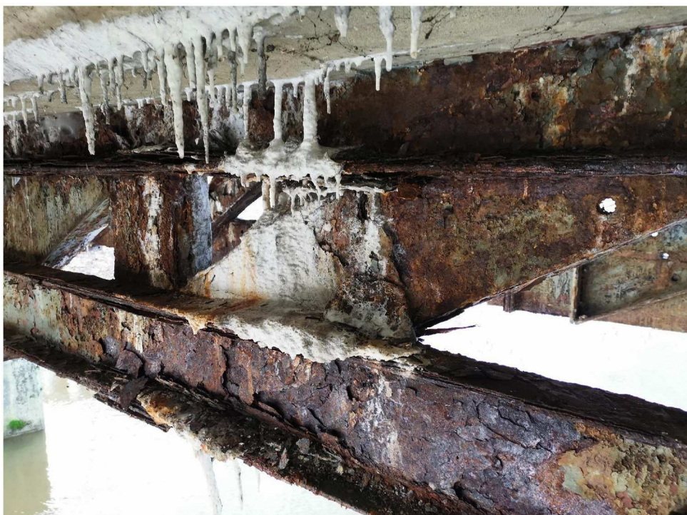
Pas dolny kratownicy przed oczyszczeniem z produktów korozji
