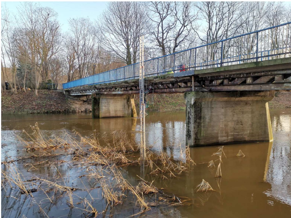
Ustawienie drabiny do pomiaru dźwigara skrajnego od strony dolnej wody
