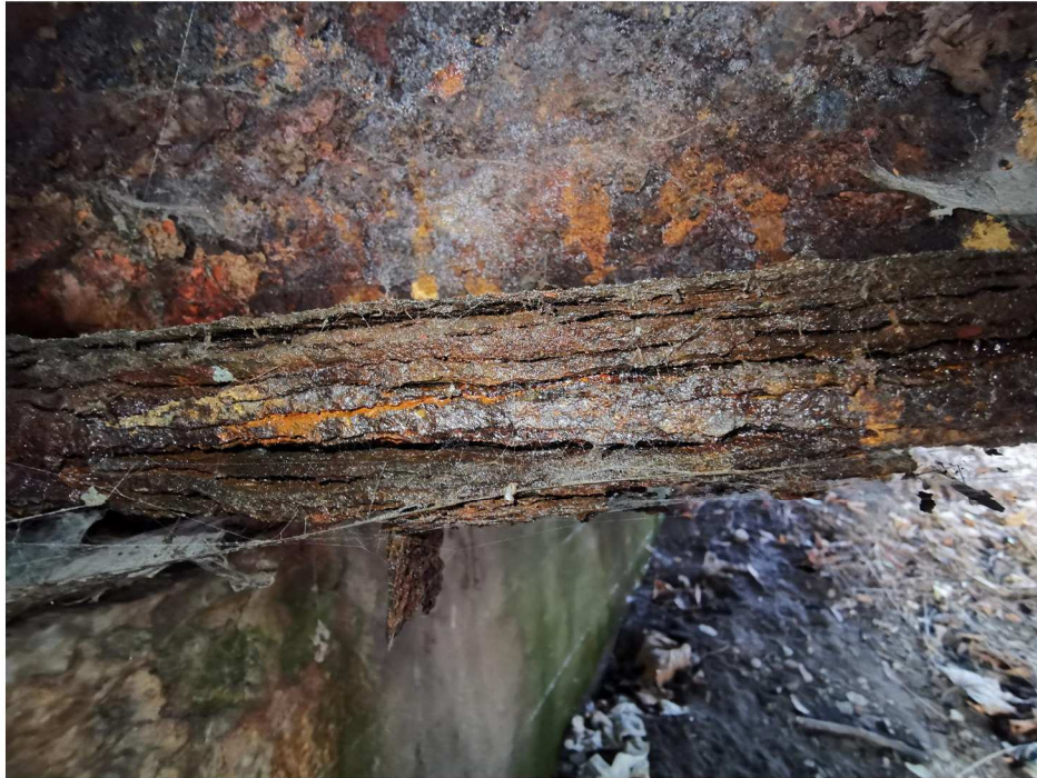
Fot. 24 Konstrukcja stalowa - zbliżenie uszkodzeń Rozległe uszkodzenia korozyjne pasa dolnego dźwigara kratownicowego.
