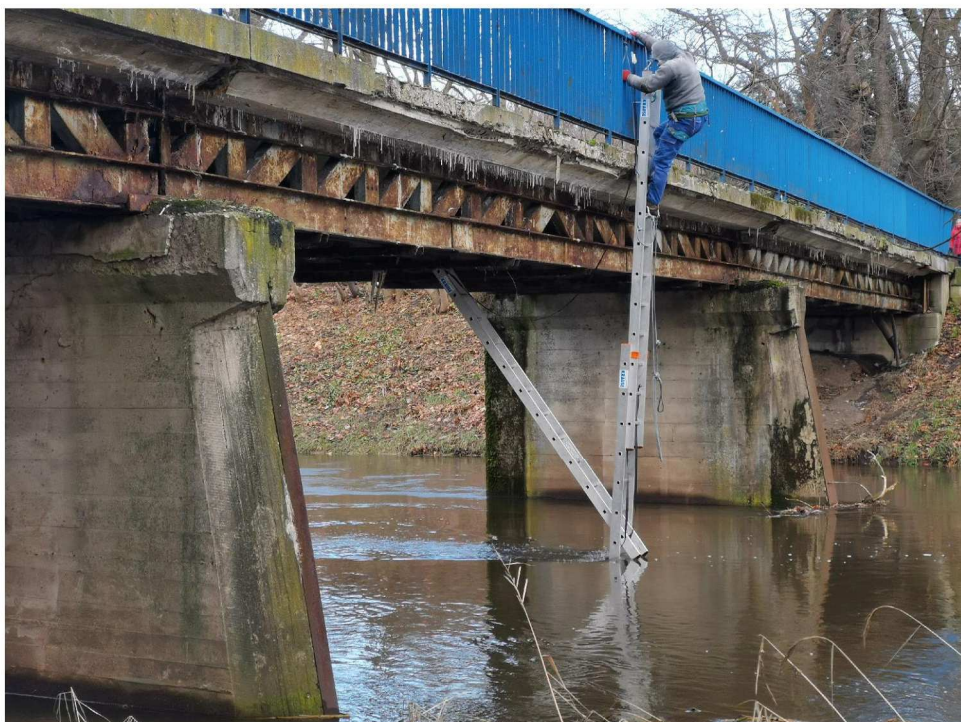
Ustawienie drabiny do pomiaru dźwigara skrajnego od strony górnej wody
