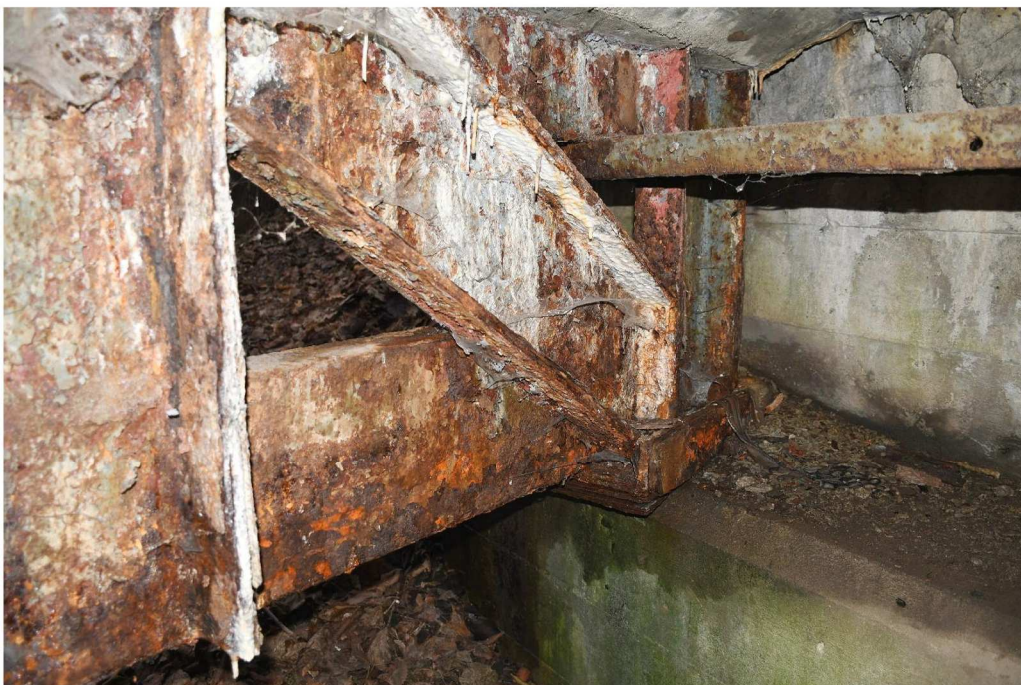
Fot. 17 Konstrukcja stalowa, przyczółek
