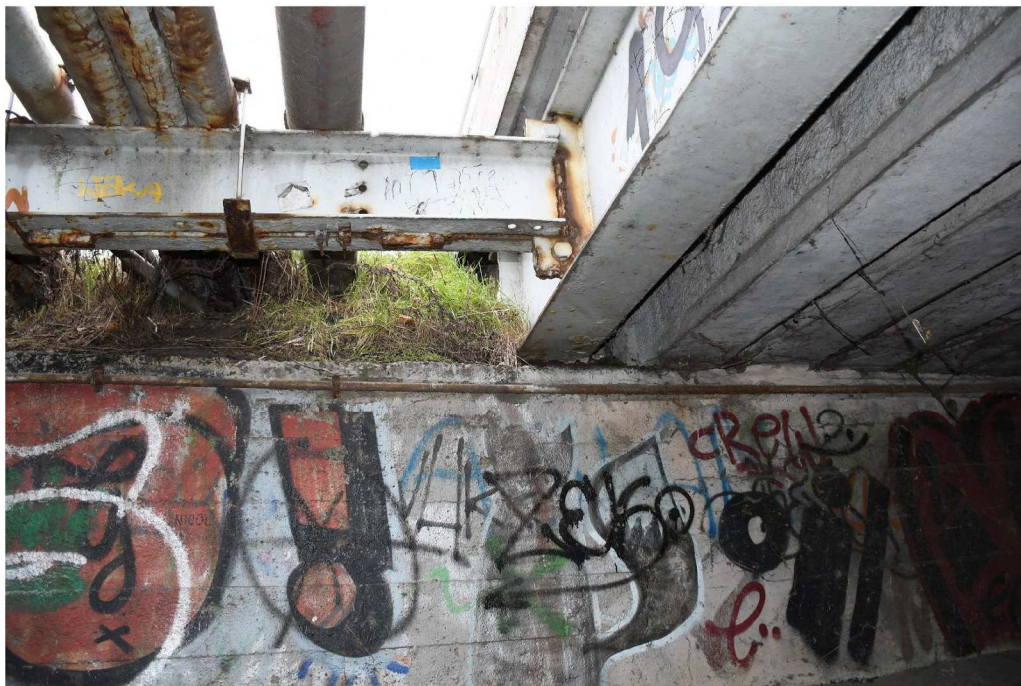
Fot. 27 Konstrukcja stalowa urządzeń obcych, przyczółek mostu
