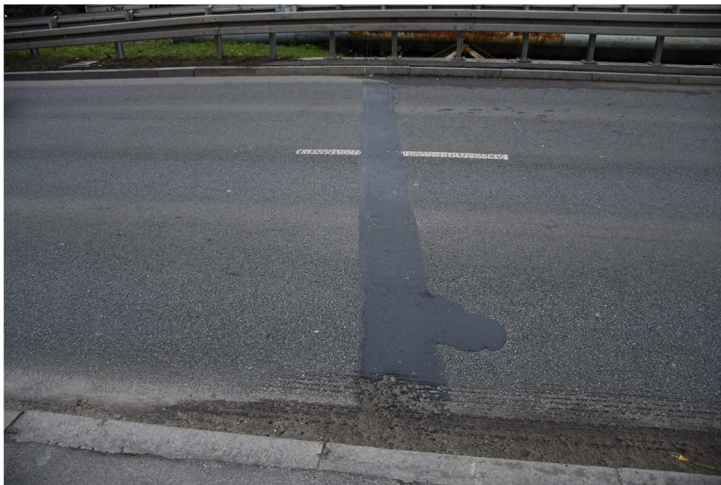
Fot. 9 Bitumiczne przykrycie dylatacyjne
