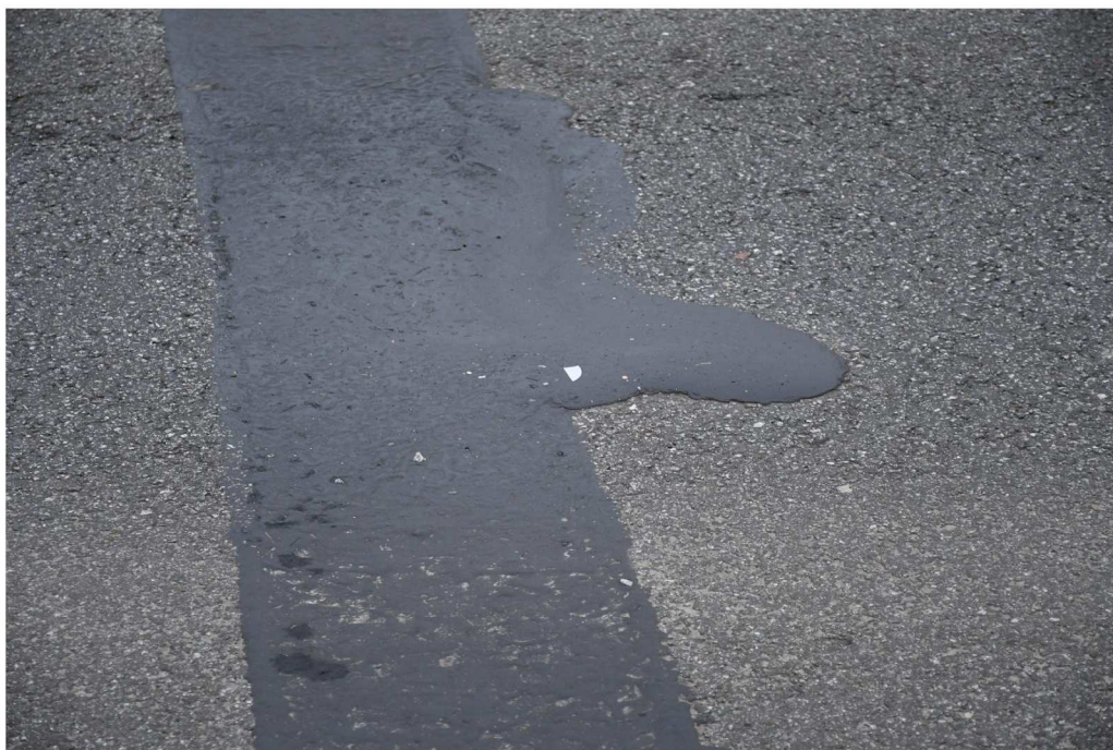
Fot. 10 Bitumiczne przykrycie dylatacyjne
