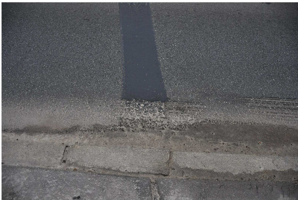
Fot. 8 Bitumiczne przykrycie dylatacyjne
