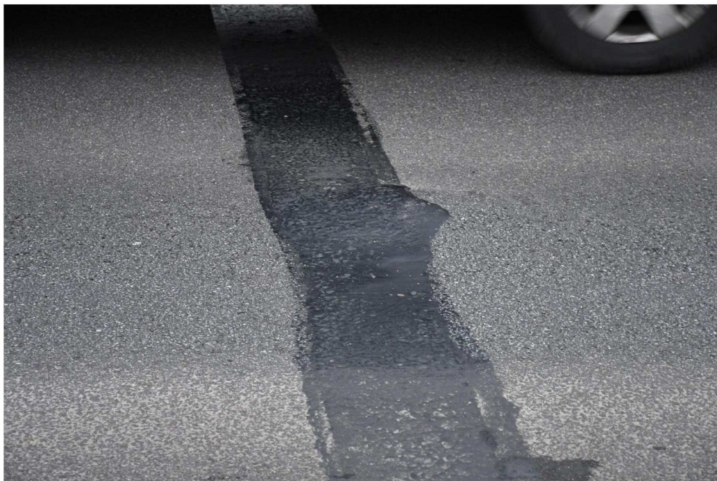
Fot. 9 Bitumiczne przykrycie dylatacyjne
