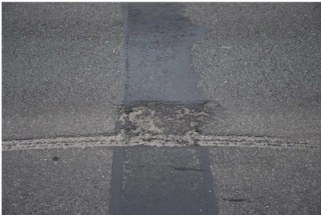
Fot. 11 Bitumiczne przykrycie dylatacyjne
