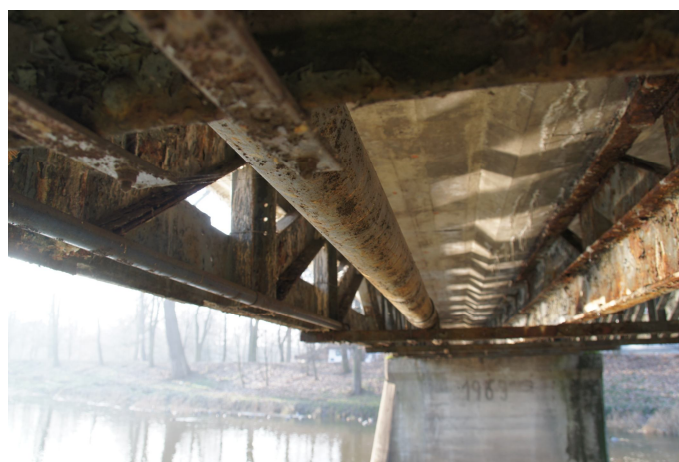
Rys. 19 Widok ogólny rurociągu podwieszonego do konstrukcji kładki. Widoczne braki w powłokach antykorozyjnych
