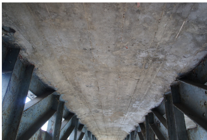
Rys. 10 Widok płyty żelbetowej pomostu. Widoczny dostateczny stan techniczny betonu płyty
