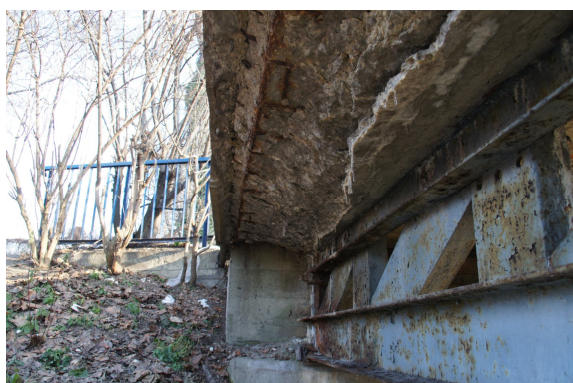
Rys. 13 Widok gzymsu od spodu od strony ul. Łódzkiej od strony dolnej wody. Widoczna degradacja betonu skrajnej części płyty pomostu i gzymsu
