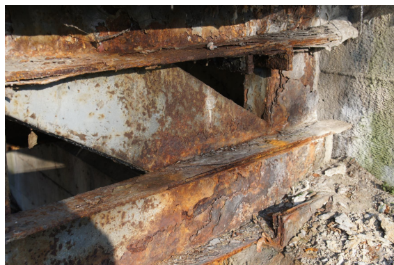
Rys. 8 Widok skrajnego dźwigara od strony górnej wody w strefie podporowej. Widoczna zaawansowana korozja powierzchniowa dźwigara i skrajnej poprzecznicy
