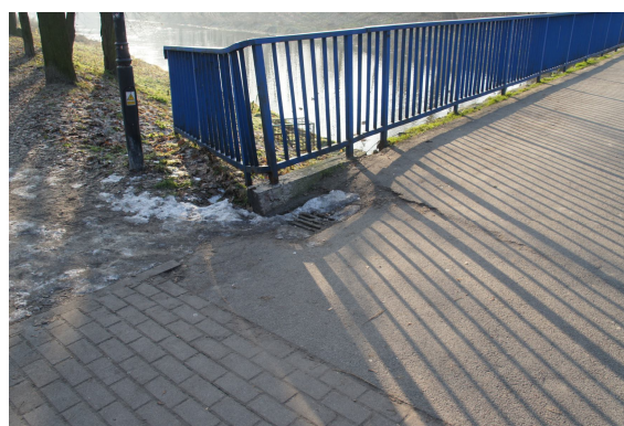
Rys. 6 Widok nawierzchni na wejściu na obiekt od strony ul. Łódzkiej. Widoczna miejscowe zapadnięcie nawierzchni w obrębie wpustu odwadniającego
