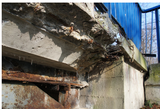
Rys. 14 Widok gzymsu od spodu od strony ul. Łódzkiej od strony górnej wody. Widoczna degradacja betonu skrajnej części płyty pomostu i gzymsu
