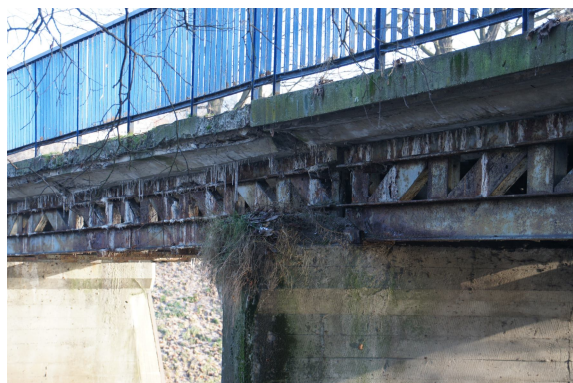
Rys. 15 Widok filara nr 1 od strony dolnej wody. Widoczna wegetacja roślinności w obrębie ciosu podłożyskowego
