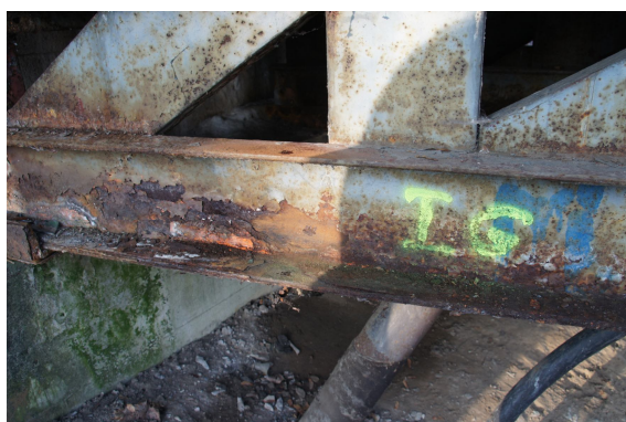
Rys. 9 Widok dźwigara skrajnego od strony górnej wody. Widoczne złuszczone powłoki antykorozyjne szczególnie w obrębie pasa dolnego
