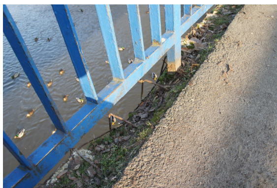
Rys. 18 Widok zakotwienia balustrady od strony dolnej wody. Widoczne miejscowe ubytki w zabezpieczeniu antykorozyjnym – w strefie zakotwienia balustrady
