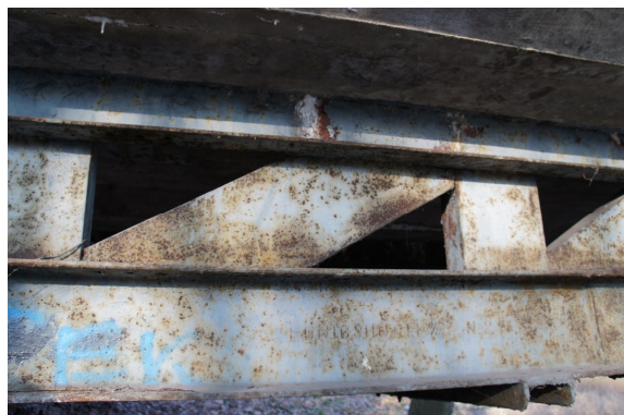
Rys. 7 Widok ogólny dźwigarów głównych mostu. Widoczna ogólna miejscowa korozja powierzchniowa elementów stalowych
