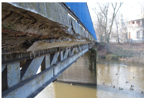
Rys. 12 Widok gzymsu od strony dolnej wody. Widoczna zaawansowana degradacja betonu gzymsu
