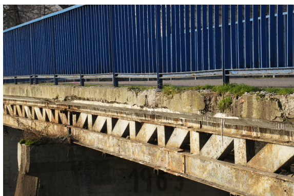
Rys. 11 Widok gzymsu od strony górnej wody. Widoczne ubytki betonu gzymsu
