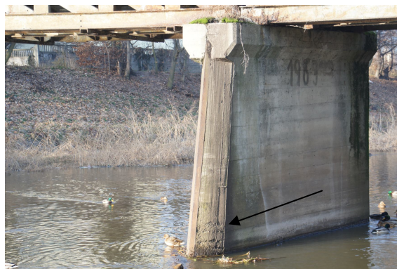
Rys. 16 Widok filara nr 2 od strony górnej wody. Widoczne miejscowe ubytki betonu w strefie kontaktu z wodą
