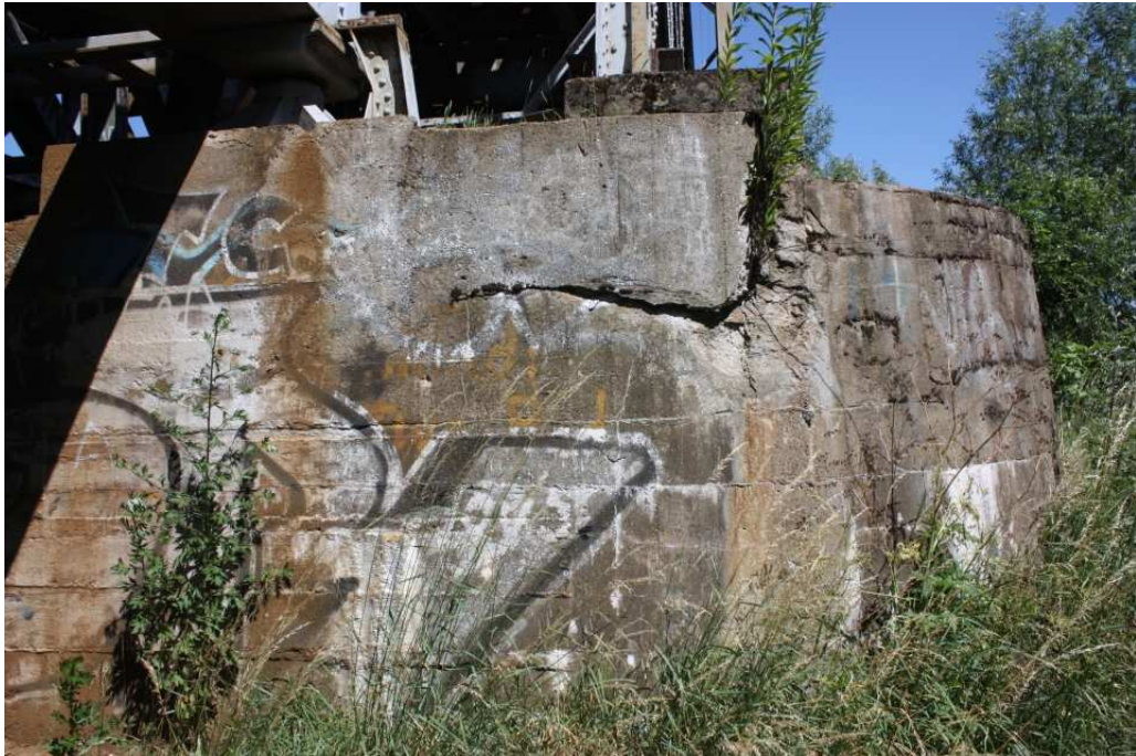
Rysy i pęknięcia na filarze
