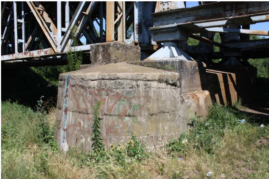
Rysy i pęknięcia na filarze
