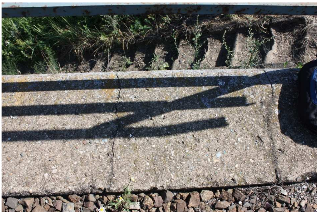
Rysy i pęknięcia na gzymsie skrzydła
