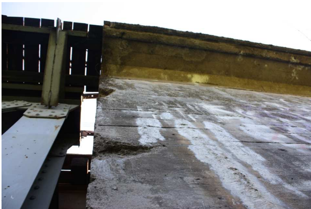
Rysy i pęknięcia na skrzydle
