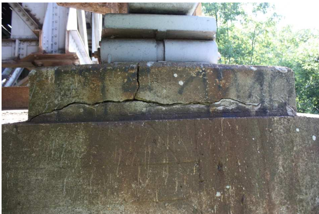
Pęknięty cios podłożyskowy
