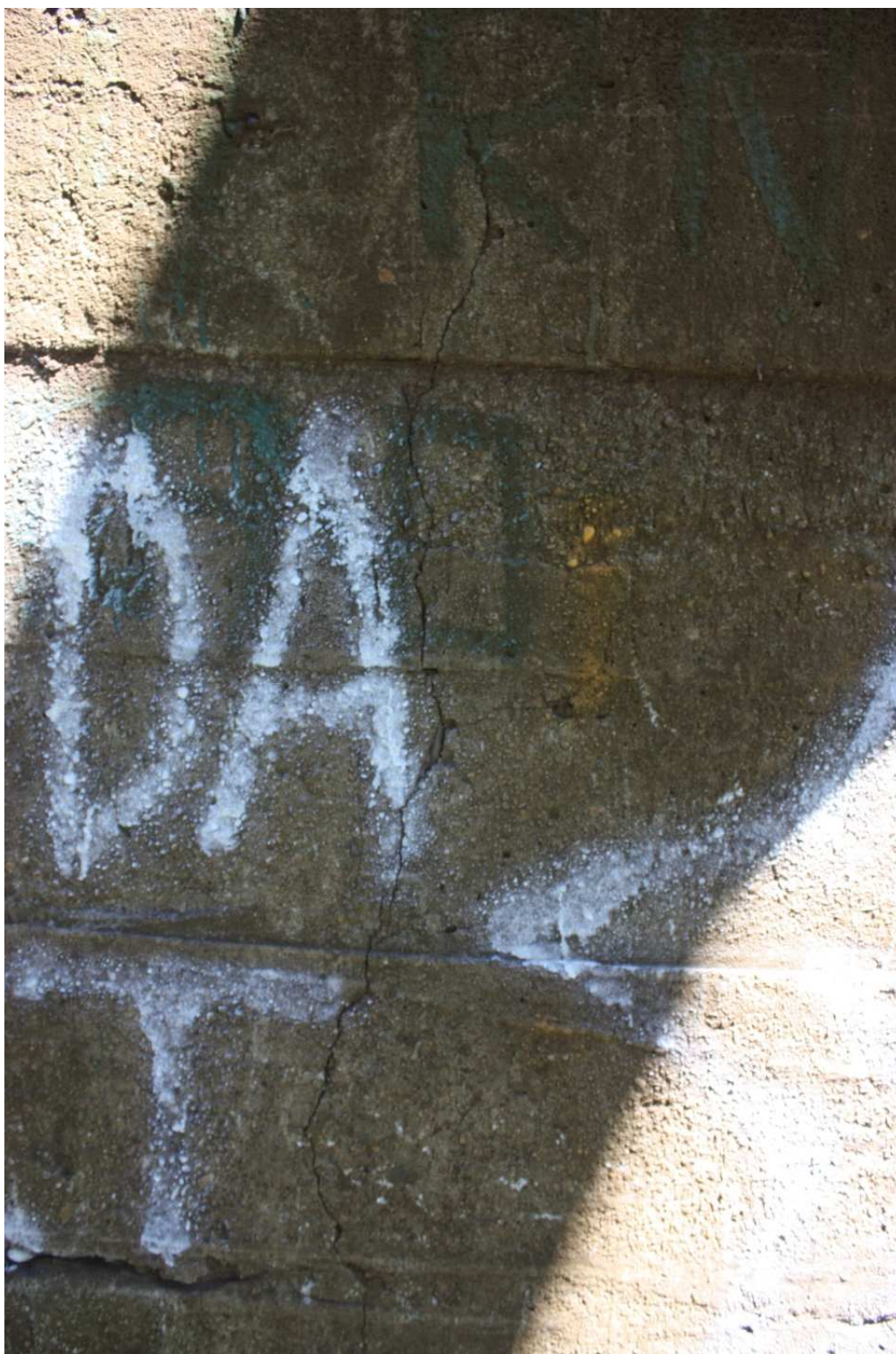
Rysy i pęknięcia na filarze
