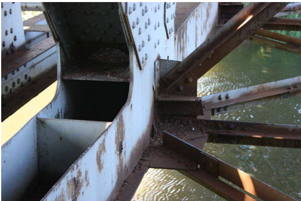
Ślady rdzy na pasie dolnym, krzyżulcach, poprzecznicach, wiatrownicach oraz skorodowana blacha węzłowa
