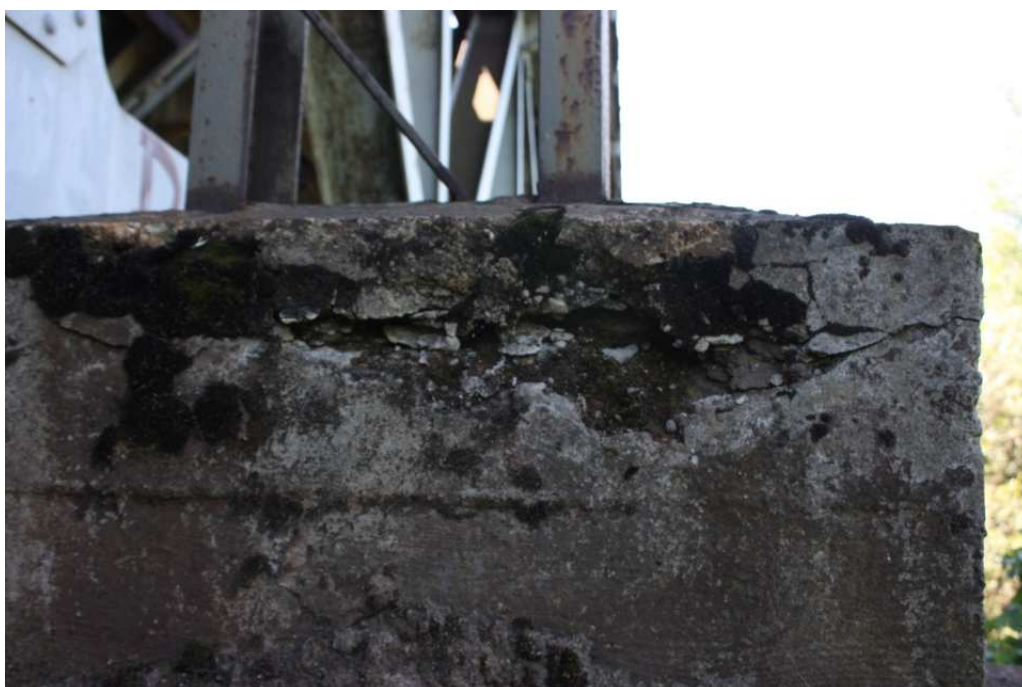
Rysy i pęknięcia na fundamencie słupa trakcyjnego
