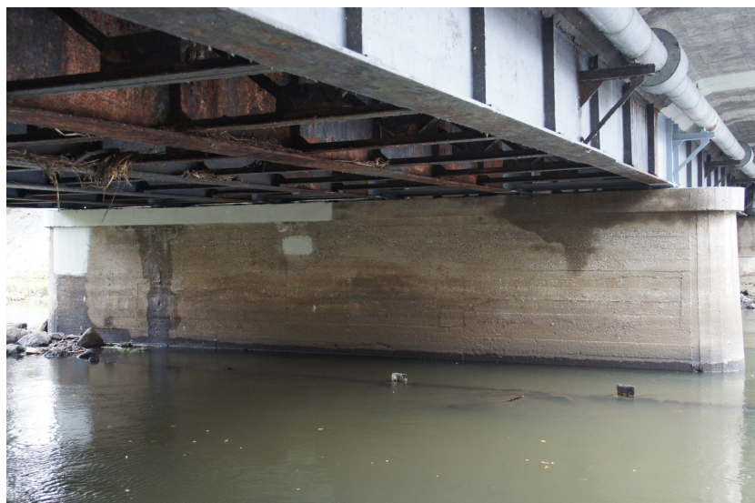
Rys. 20 Widok ogólny filara mostu. Widoczne zacieki wynikające z nieszczelności urządzenia dylatacyjnego
