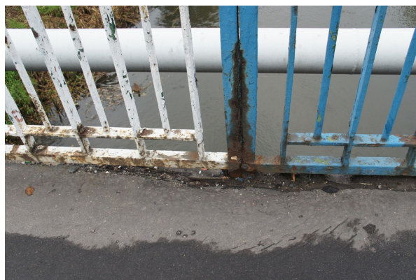
Rys. 22 Widok balustrady od strony dolnej wody. Widoczna korozja słupków oraz braki w powłokach malarskich
