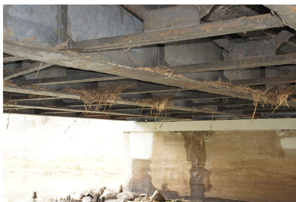
Rys. 15 Widok dźwigarów przęsła nr 2. Widoczne zanieczyszczenie konstrukcji spowodowane wysokimi stanami wód w rzece Prosna
