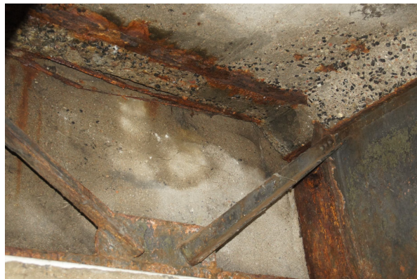
Rys. 11 Szczegół przerwy dylatacyjnej w obrębie przyczółka od strony ul. Wodnej. Widoczna zaawansowana korozja dźwigarów głównych, skrajnego stężenia oraz korozja betonu
