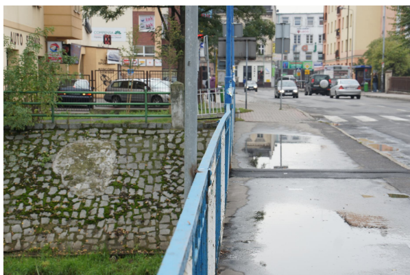
Rys. 21 Widok balustrady od strony górnej wody. Widoczna niewielka nieliniowość pochwyty balustrady
