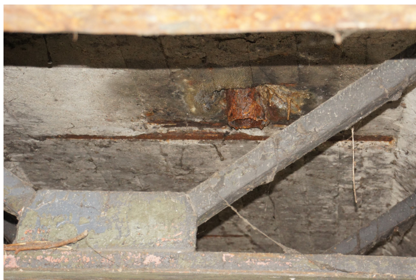
Rys. 9 Szczegół rury spustowej odwodnienia. Widoczna zaawansowana korozja żeliwnej rury spustowej oraz degradacja płyty pomostowej w obrębie odwodnienia
