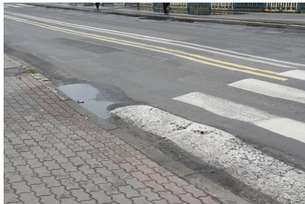
Rys. 7 Widok nawierzchni na dojeździe od strony ul. Wodnej. Widoczna znaczna nierówność w obrębie przejścia dla pieszych
