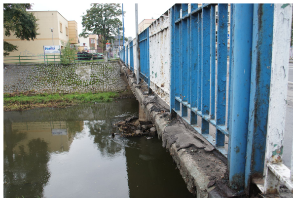
Rys. 19 Widok gzymsu od strony górnej wody. Widoczne ubytki w nawierzchni chodnika skutkujące degradacją betonu gzymsów
