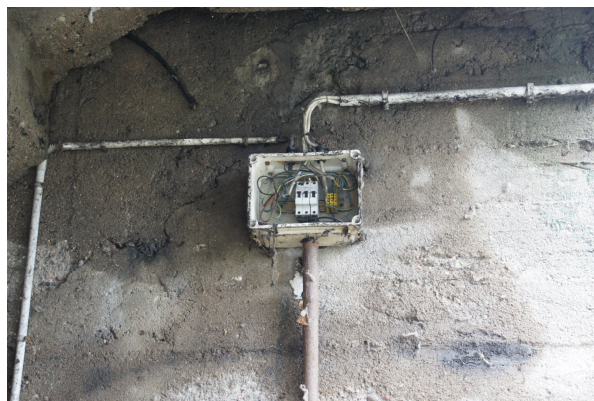
Rys. 25 Widok skrzynki rozdzielczej na ścianie przyczółka prawobrzeżnego. Widoczny brak osłon przeciwporażeniowych
