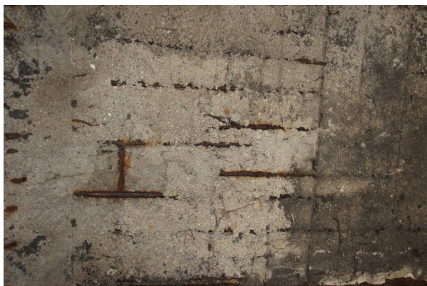
Rys. 16 Widok płyty pomostu od spodu w przęśle nr 2. Widoczna korozja betonu i brak otuliny prętów zbrojenia
