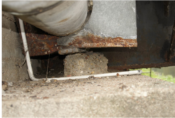
Rys. 25 Szczegół prowizorycznego podparcia kolana rurociągu od strony dolnej wody
