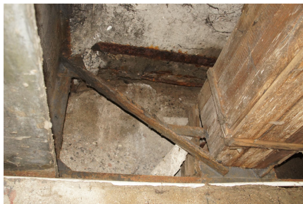
Rys. 17 Widok płyty pomostu przęsła nr 2 w strefie przypodporowej. Widoczna zaawansowana korozja betonu płyty
