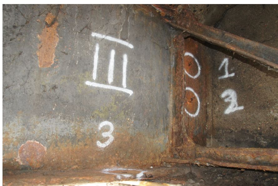
Rys. 28 Seria pomiarów III – środek oraz dolny pas dźwigara nr 6 w przęśle nr 2
