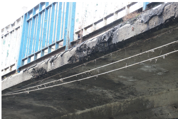
Rys. 23 Widok przewodów elektrycznych od strony górnej wody. Widoczne braki w łącznikach przewodów
