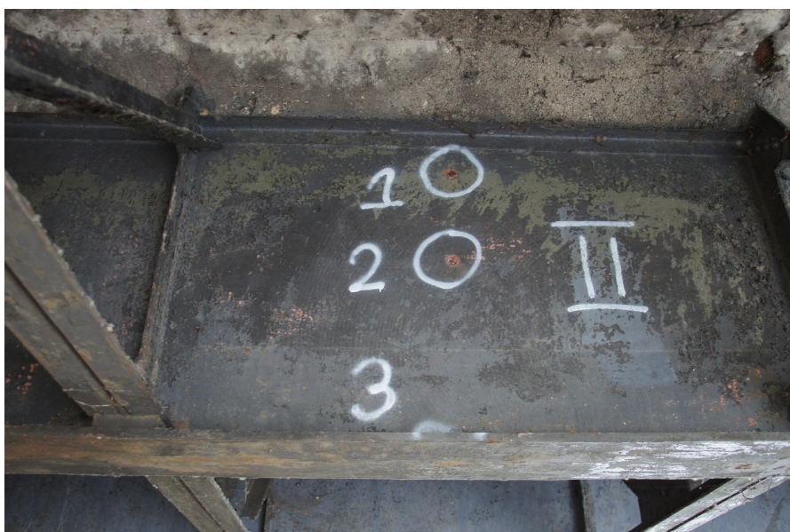
Rys. 27 Seria pomiarów II – środek oraz dolny pas dźwigara nr 5 w przęśle nr 2
