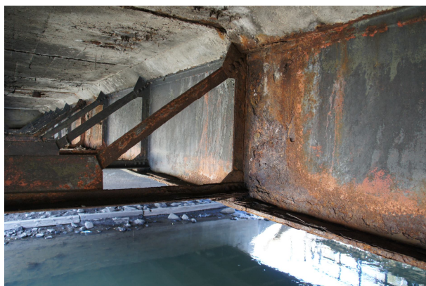
Rys. 12 Widok dźwigara nr 3 przęsła nr 1. Widoczna miejscowa korozja powierzchniowa w obrębie nieszczelności izolacji pomostu
