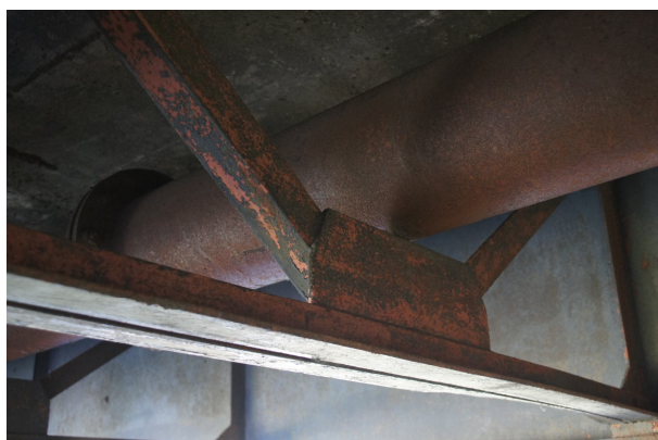
Rys. 14 Widok stężenia przęsła nr 1. Widoczne złuszczone powłoki antykorozyjne
