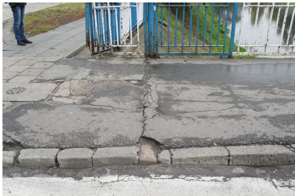
Rys. 10 Widok nawierzchni chodnika w obrębie dylatacji. Widoczne liczne spękania nawierzchni
