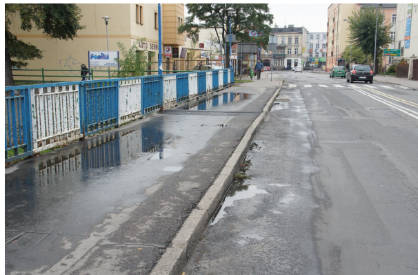
Rys. 6 Widok nawierzchni jezdni. Widoczne nierówności oraz spękania nawierzchni w obrębie krawężnika
