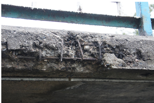
Rys. 18 Widok gzymsu od strony dolnej wody. Widoczny brak otuliny prętów zbrojeniowych gzymsu
