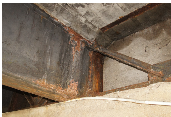
Rys. 13 Widok dźwigara nr 4 przęsła nr 2 w strefie podporowej. Widoczna zaawansowana korozja dźwigara spowodowana nieszczelnością dylatacji
