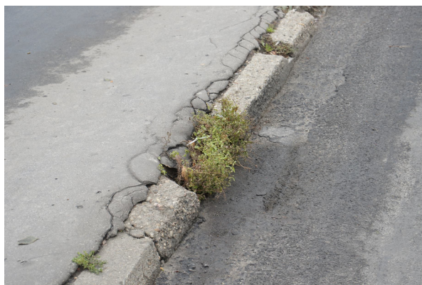
Rys. 9 Szczegół krawężnika od strony dolnej wody. Widoczne znaczne ubytki krawężników oraz wegetacja roślin
