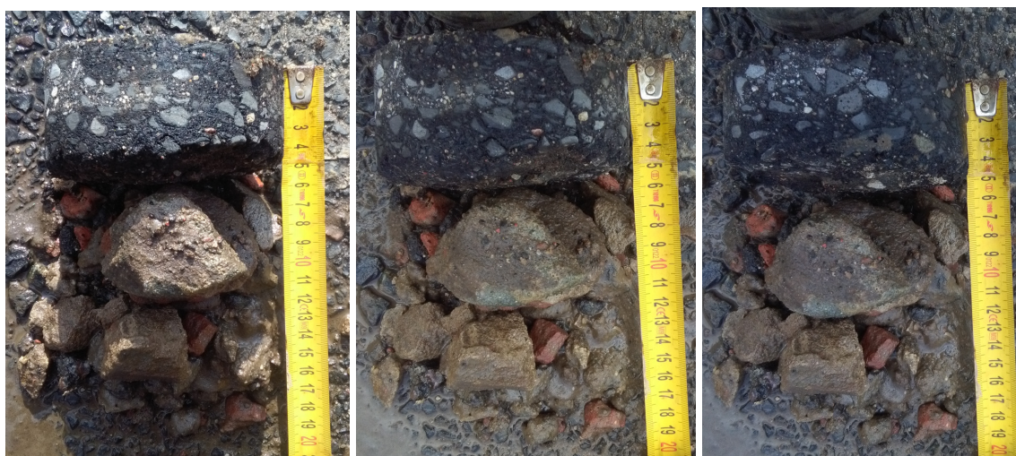
Rys. 3. Warstwa nawierzchni asfaltowej o grubości ~5 cm, rozpoznana w punkcie badawczym nr 6.
